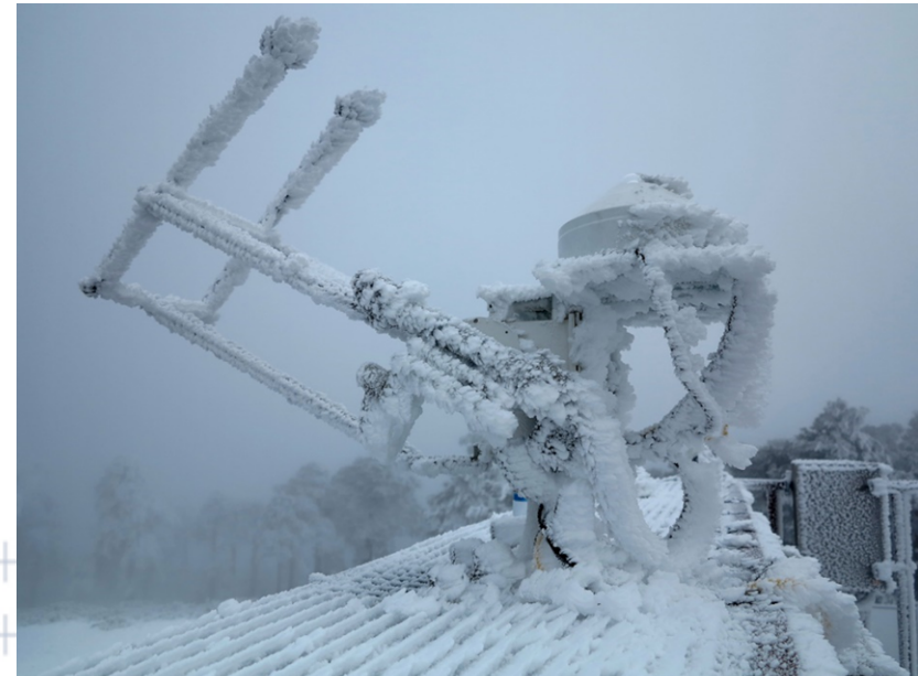
Estación radiométrica del Puerto de Navacerrada (Madrid)
