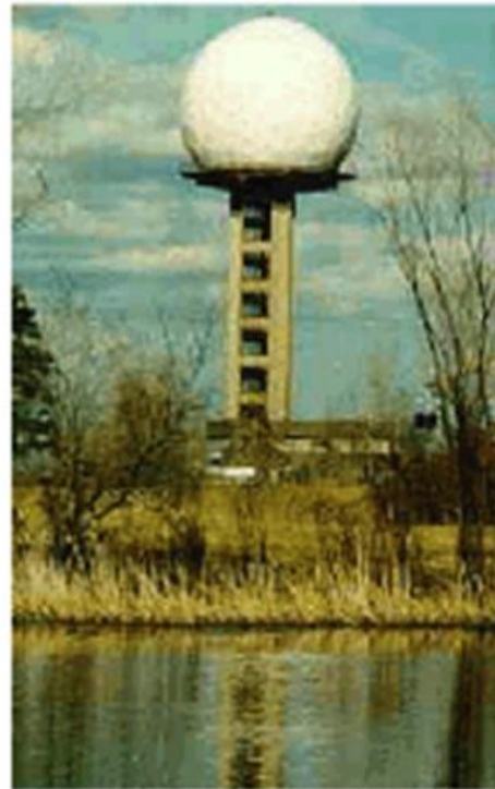
Radars de banda S del Marshall radar Observatory (MRO), en Montreal, Canadá, con un disco de unos 10 m de diámetro
