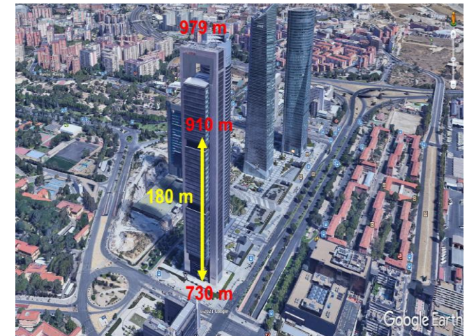
Sin embargo, para un observador situado en la puerta principal del edificio, la altitud sería menor: unos 180 metros, ya que esa entrada está situada a mayor altitud que el punto de observación de la fotografía de la izquierda.
